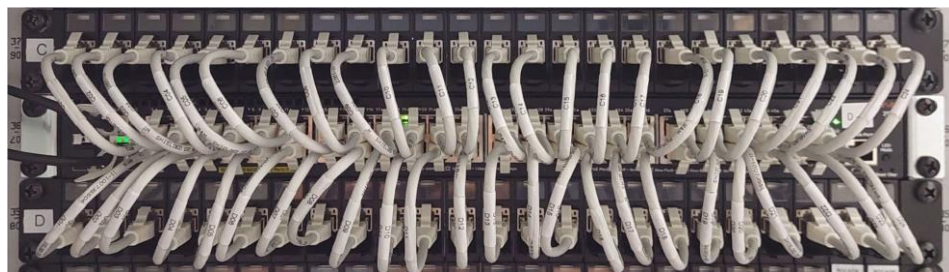
Figure 5 - Brassage de deux panneaux RJ45 sur un commutateur 48 ports
